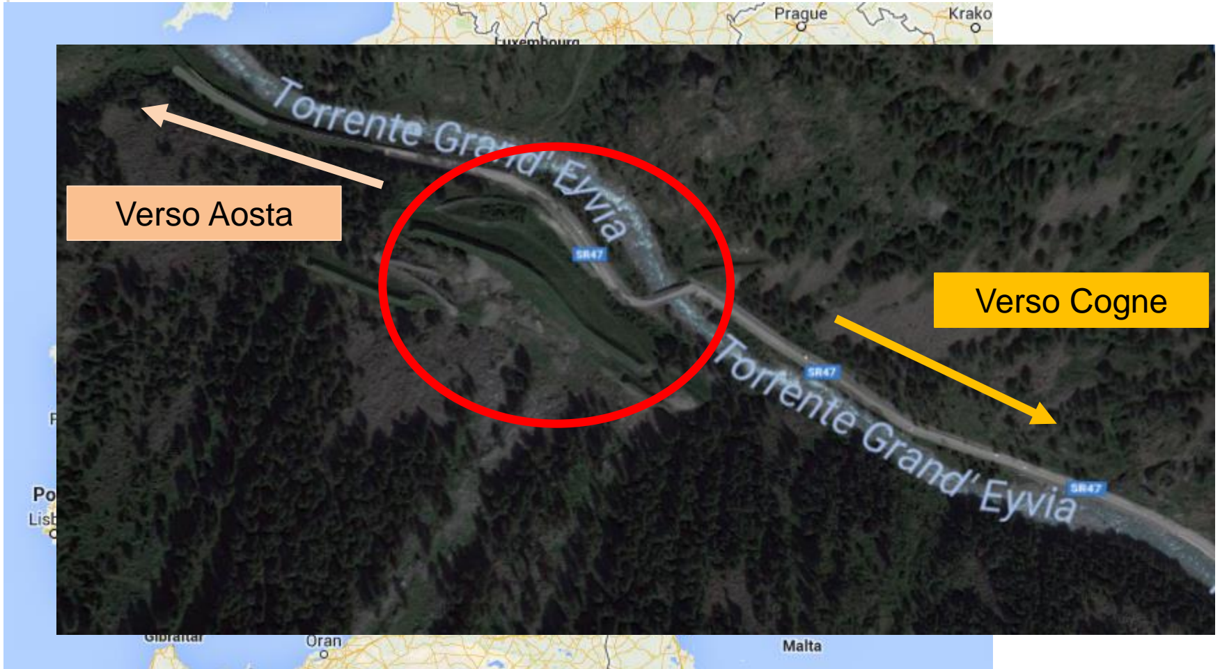
Comune di Cogne (Aosta, Ita) - Strada Regionale 47 – km 15+800
