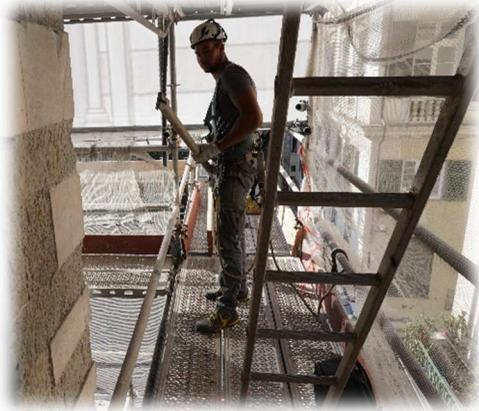
L'accesso alla zona del ponteggio ove è stato rimosso il parapetto è limitato, mediante barriere e segnalazioni, ai soli lavoratori direttamente impegnati nella lavorazione, muniti dei necessari dispositivi di protezione.
