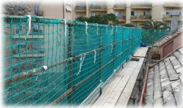
Nello stabilire i requisiti del parapetto devono essere definiti, oltreché la distanza massima fra i correnti, realizzabile anche con l'interposizione di una rete anti-caduta adatta alla posa verticale (cfr. capitolo 3), l'eventuale irrigidimento della struttura ed implementazione degli ancoraggi, anche larghezza e quota dell'impalcato rispetto alla gronda.
