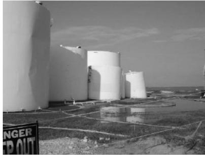
Shell buckling di un serbatoio durante un'alluvione generata dall'uragano Katrina
