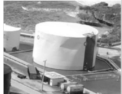
Shell buckling di un serbatoio per carico di vento generata dall'uragano Katrina
