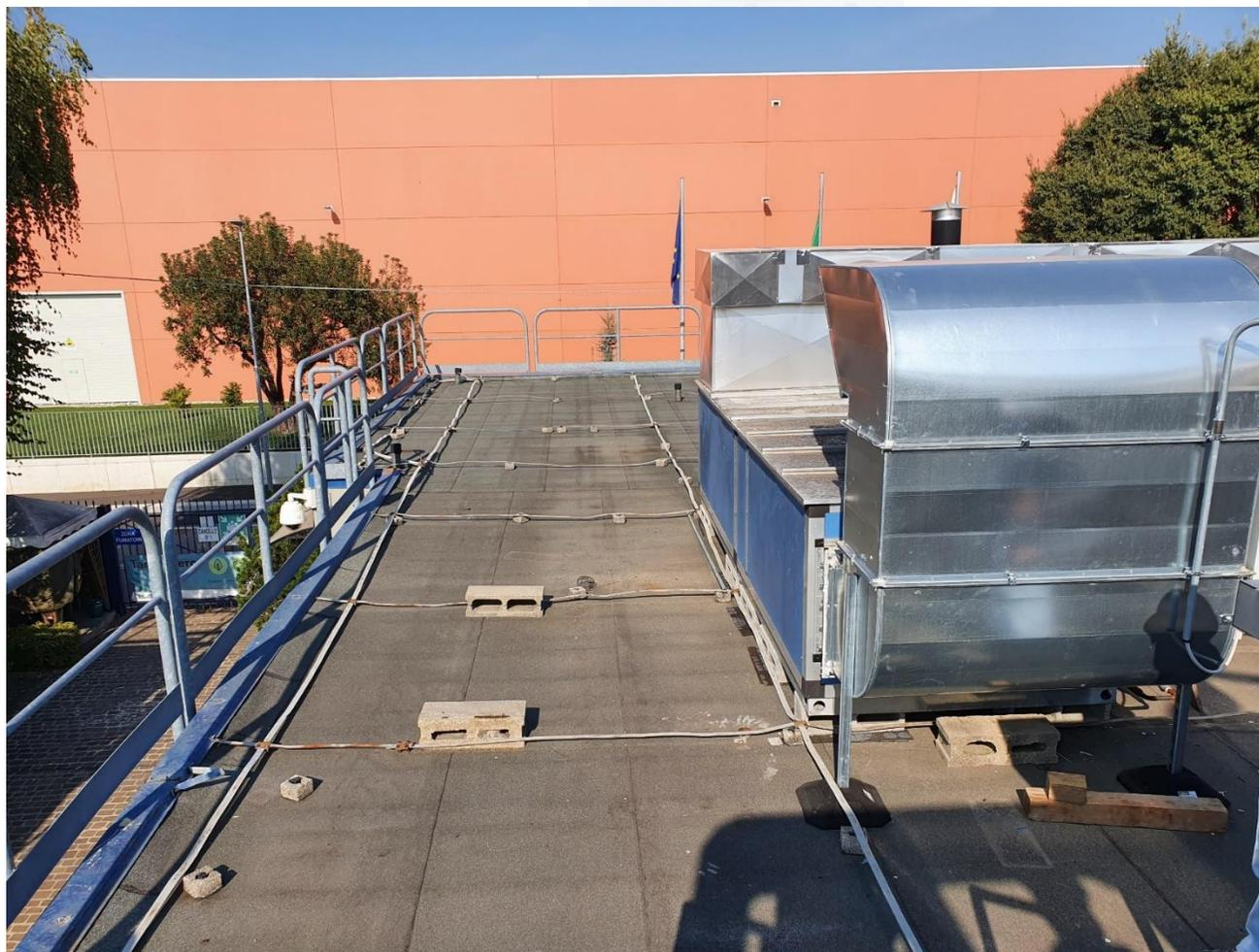
Su strutture dotate di LPS, interventi in copertura o sulle pareti con l'installazione di nuovi impianti o apparecchiature, devono essere **coordinati con il progettista elettrico**, per verificare che non venga vanificata la funzionalità dell'impianto.
